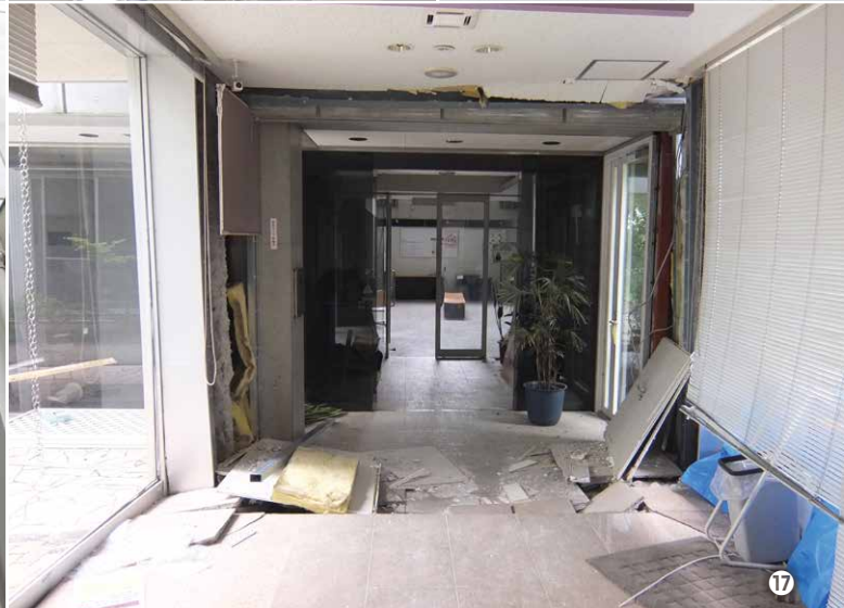
⑦擁壁の一部が損壊した第1駐車場 ⑧壁面が剥がれ崩れ落ちた管理棟内の階段 ⑨病室 ⑩病院西側の境界線 ⑪管理棟と診療棟をつなぐ通路の激しい地盤沈下 ⑫急性期治療病棟玄関前の地盤沈下 ⑬病棟本館と急性期治療病棟の渡り廊下断裂 ⑭病棟本館と管理棟通路の断裂 ⑮事務局噴水側通路ブロックの破壊 ⑯病棟 本館と急性期治療病棟の渡り廊下断裂 ⑰管理棟から診療棟への通路破断
