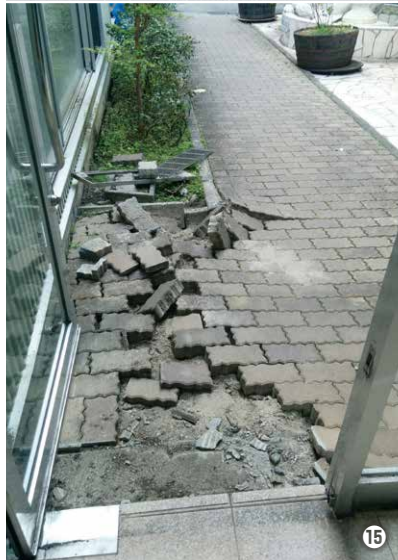
⑦擁壁の一部が損壊した第1駐車場 ⑧壁面が剥がれ崩れ落ちた管理棟内の階段 ⑨病室 ⑩病院西側の境界線 ⑪管理棟と診療棟をつなぐ通路の激しい地盤沈下 ⑫急性期治療病棟玄関前の地盤沈下 ⑬病棟本館と急性期治療病棟の渡り廊下断裂 ⑭病棟本館と管理棟通路の断裂 ⑮事務局噴水側通路ブロックの破壊 ⑯病棟 本館と急性期治療病棟の渡り廊下断裂 ⑰管理棟から診療棟への通路破断
